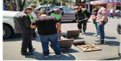
Además del análisis de la calidad de agua, se realiza desazolve del drenaje.
